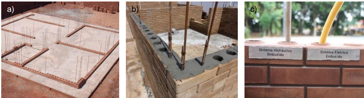
Figura 8 - Construção com BTC: a) Laje de fundação e primeira fiada, b) Levantamento das paredes e pilares, c) Sistemas hidráulicos e elétricos (EcoMáquinas, 2020).
