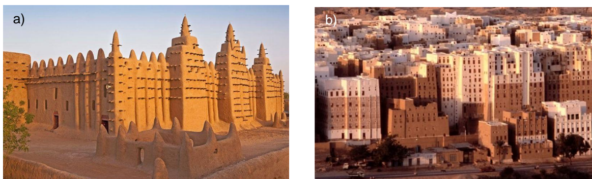
Figura 1 – Construções em terra: a) Mesquita Djenné (Mundo, 2015), Mali; b) Cidade de Shibam, Iêmen (Zero, 2020).
